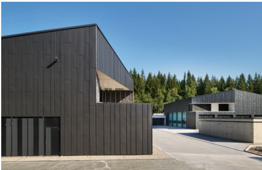
Werkhof mit Mehrzweck- und Werkstattgebäude
