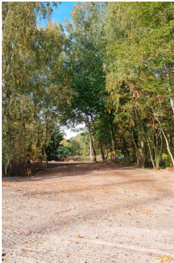
Der Abriss der Ferkelstallanlage in Dahlenberg erfolgte unter besonderer Schonung des bestehenden Baumbestandes auf der Fläche.
