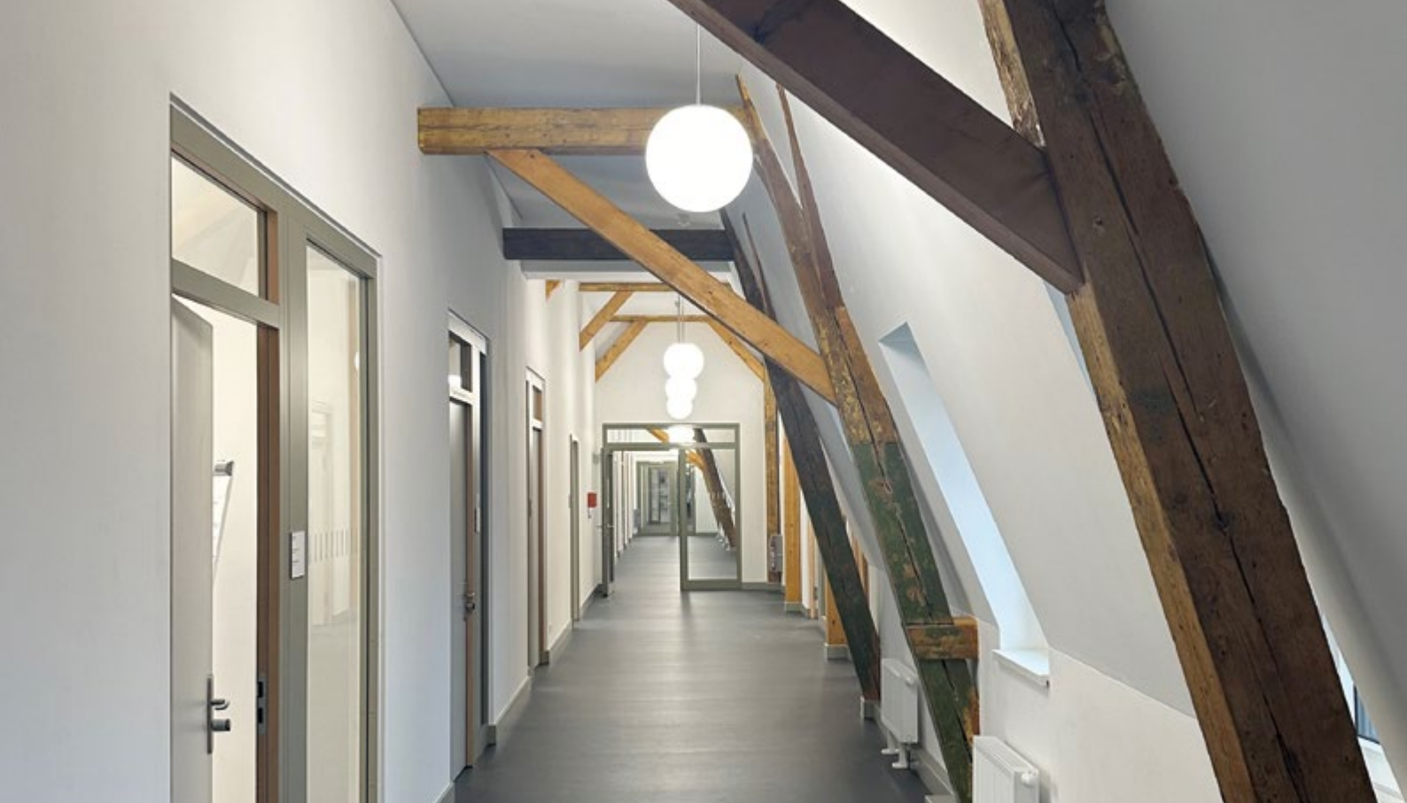
Das Holztragwerk im Dachgeschoss wurde behutsam saniert und in Szene gesetzt.
