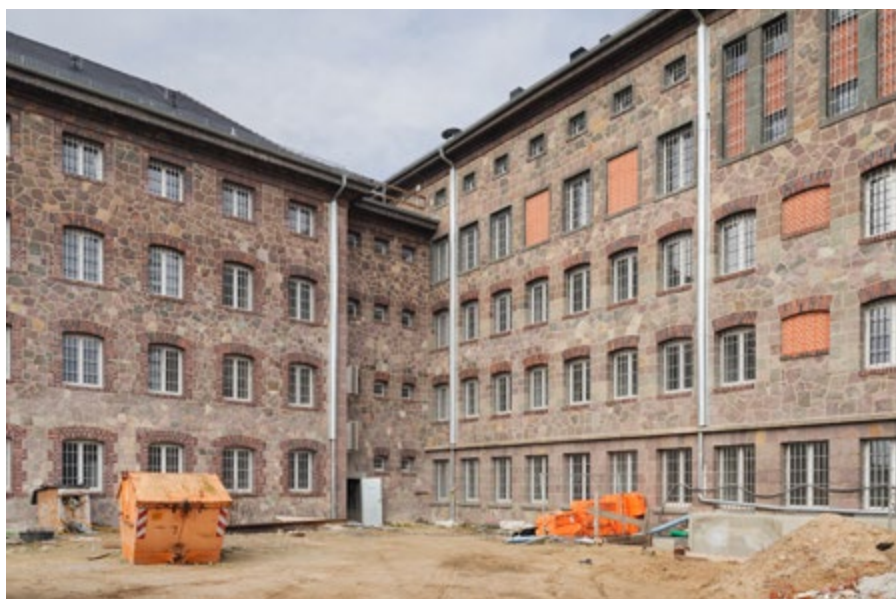
Fassade aus Zyklopen- und Klinkermauerwerk in Naturstein
