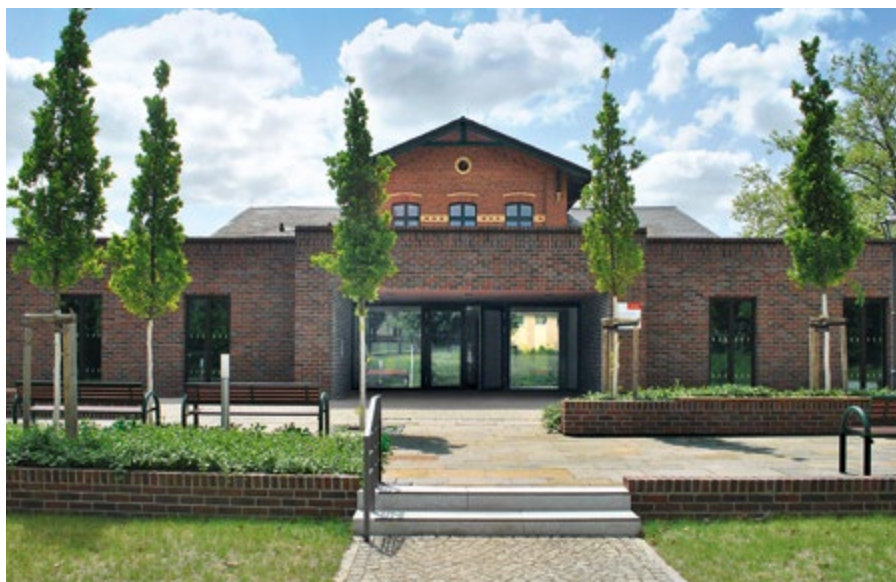
Neubau im Pavillonstil
