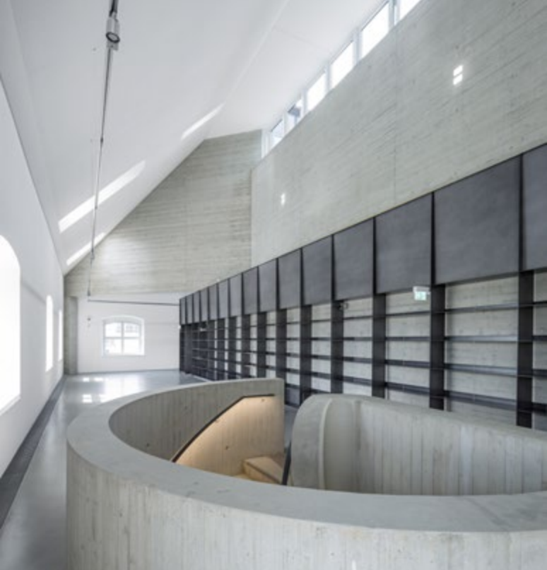
Treppenaufgang aus Sichtbeton
