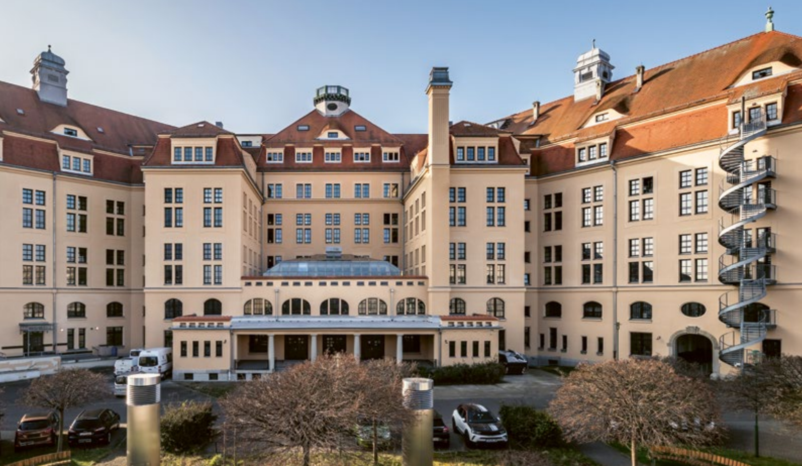
Sanierung der Nordfassade des Finanzamtes Leipzig I
