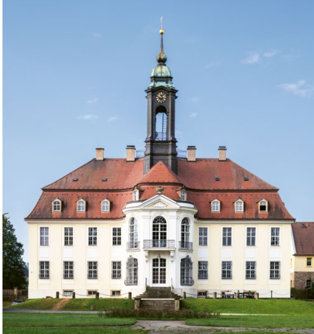
Sanierung der Außentreppe und Fenster von Schloss Reinhardtsgrimma
